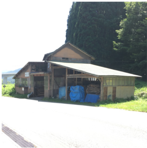
▼資材倉庫 外観
