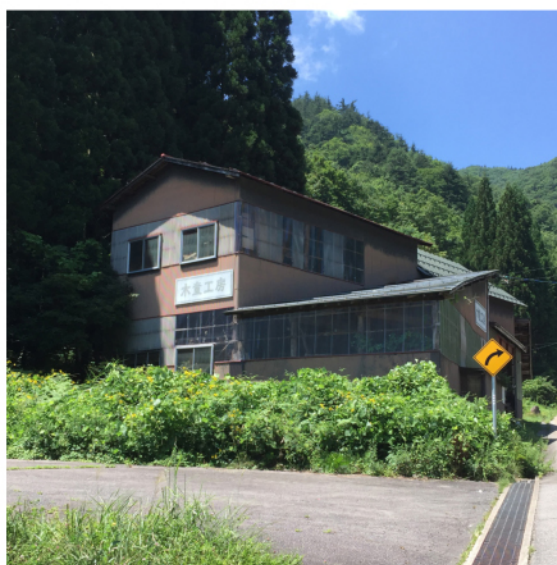
▼資材倉庫 外観
